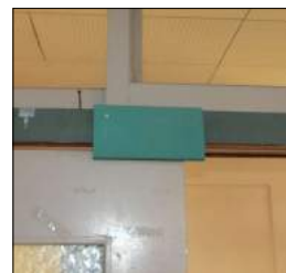
ドアが倒れないよう板がレールの横に打ち付けてある
